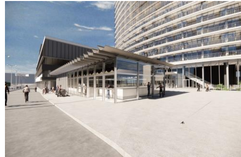
Nouveaux kiosques sur le parvis
